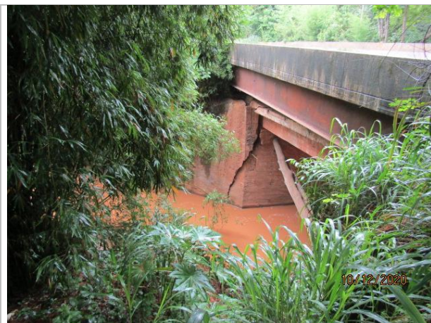
Figura 5. Vista geral da obra
