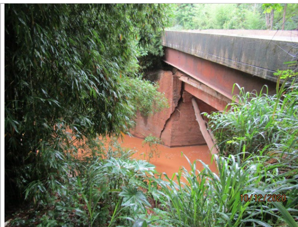
Figura 5 - Vista geral da obra
