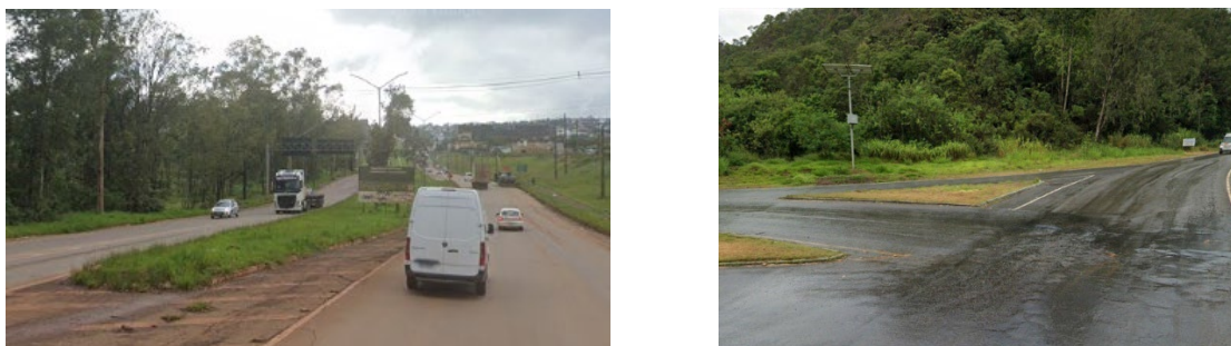
Figura 1 - Imagem ilustrativa do início e fim do trecho da BR-356
