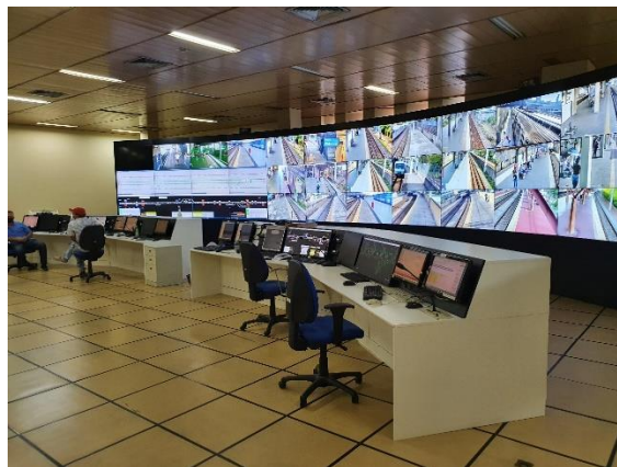
Figura 3-8 CCO, cujos painéis sinóticos foram substituídos por TVs com bordas finas
