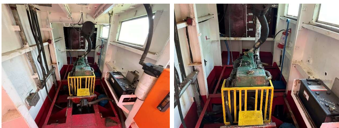
Figura 43 - Balsa Delfinópolis I - Casa de Máquinas
