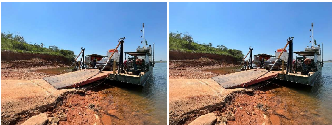
Figura 227 - Porto Harmonia - Atracadouro Existente - Margem Centro
