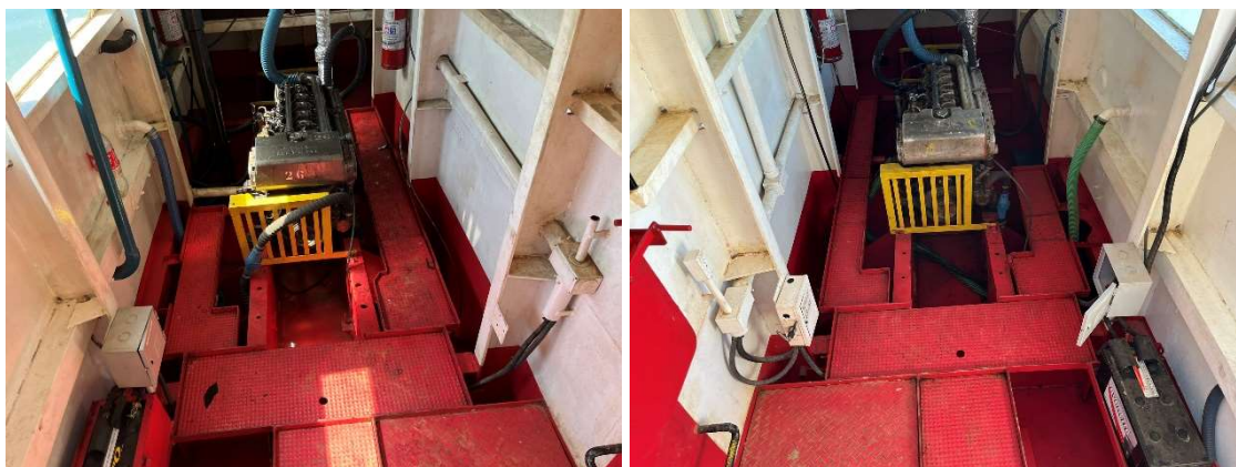
Figura 156 - Balsa Itapiché - Vista Casa de Máquinas
