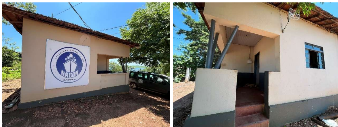
Figura 15 - Porto Delfinópolis - Prédio Administrativo
