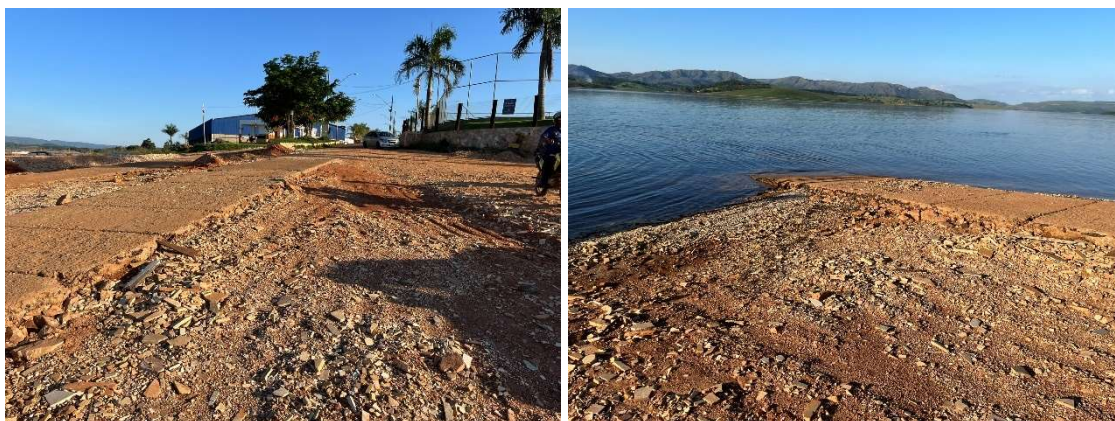
Figura 83 - Porto Araújo - Atracadouro Existente - Margem Esquerda
