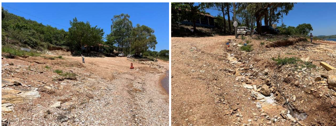
Figura 61 - Porto Pontal/Penas - Pátio do Terminal - Margem Guapé
