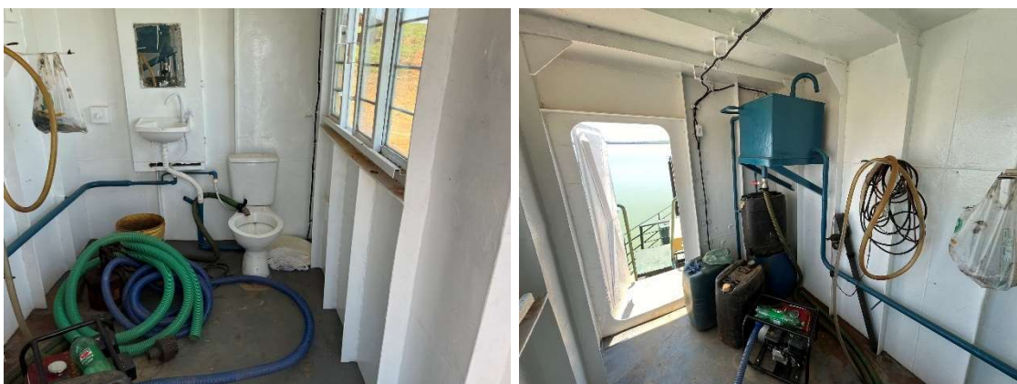
Figura 139 - Porto Fernandes - Balsa Fernandes - Banheiro
