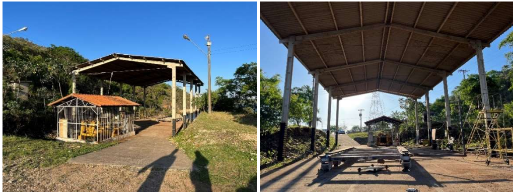
Figura 3 - Estaleiro FURNAS - Estrutura Metálica
