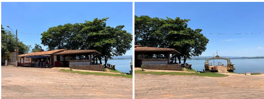
Figura 11 - Porto Delfinópolis - Pátio Terminal - Margem Delfinópolis
