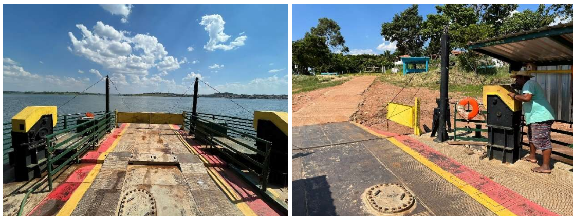
Figura 258 - Porto Fama - Balsa Araúna - Rampa de Acionamento Manual
