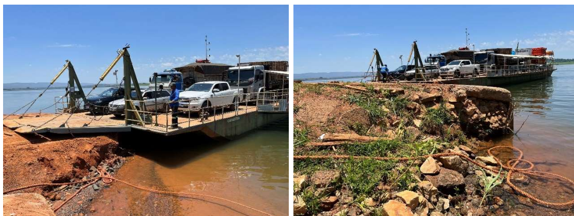
Figura 13 - Porto Delfinópolis – Atracadouro - Margem Delfinópolis
