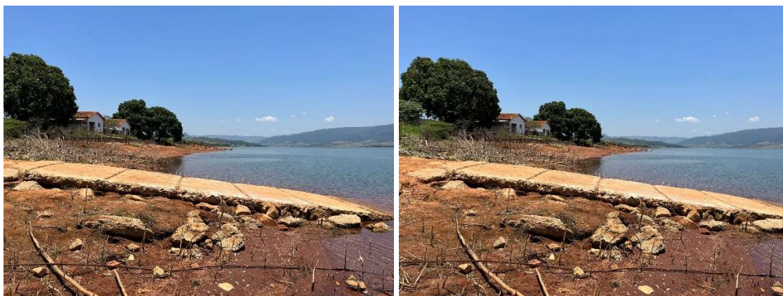
Figura 129 - Porto Fernandes - Atracadouro Margem Guapé
