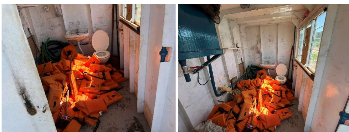
Figura 158 - Balsa Itapiché - Banheiro
