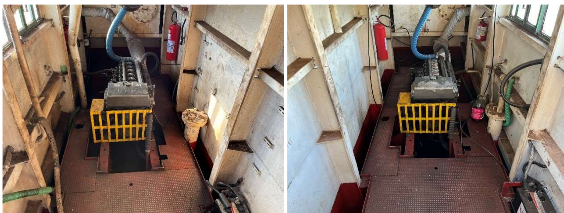
Figura 283 - Porto Pontalete - Balsa Pontalete - Casa de Máquinas
