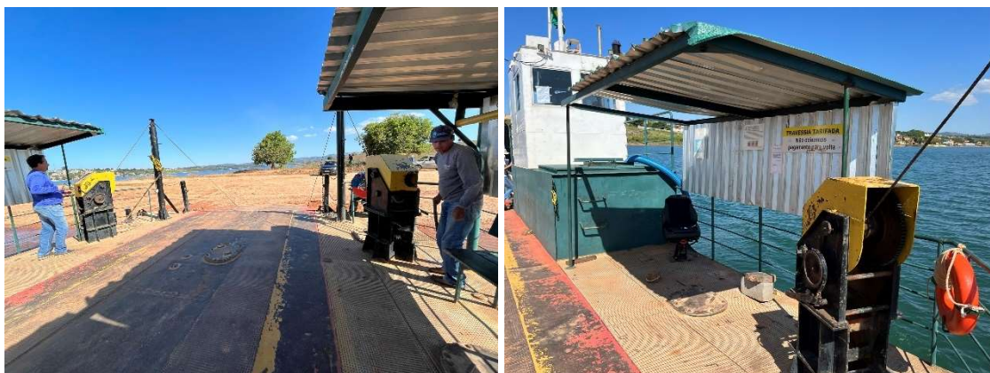
Figura 115 - Porto Barreirinho - Balsa Harmonia - Vista Mecanismos Acionamento das Rampas
