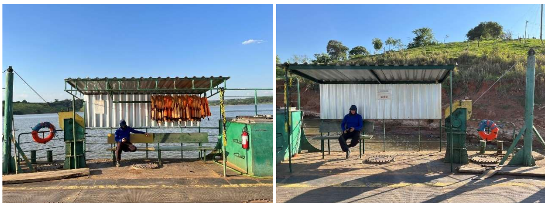
Figura 281 - Porto Pontalete - Balsa Pontalete - Abrigo de Passageiros e Equipamentos de Salvatagem
