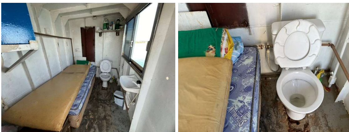
Figura 100 - Porto Araúna - Balsa São Francisco I – Banheiro
