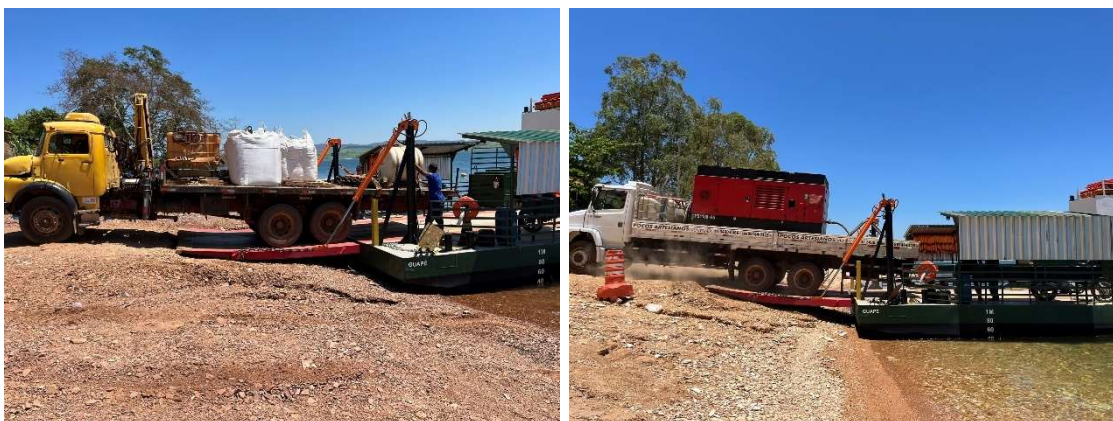
Figura 69 - Balsa Guapé - Atracação Margem Guapé
