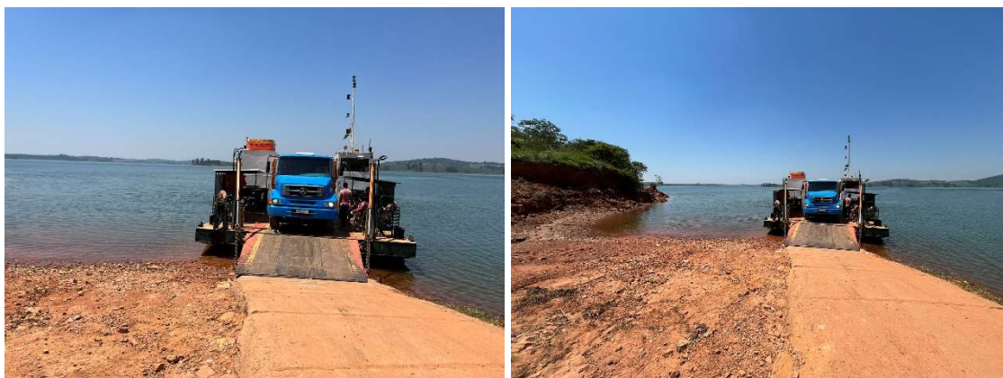
Figura 228 - Porto Harmonia - Atracadouro Existente - Margem Centro
