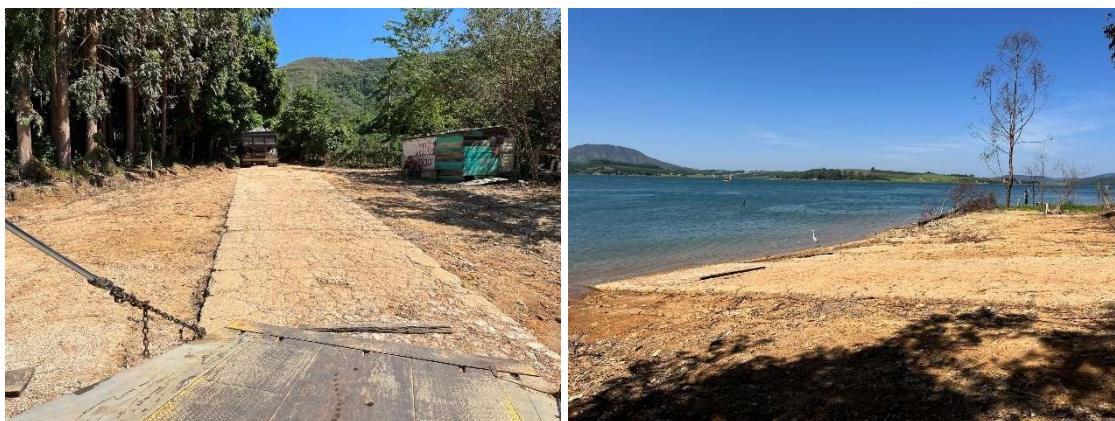
Figura 152 - Porto Itapiché - Atracadouro Margem Esquerda
