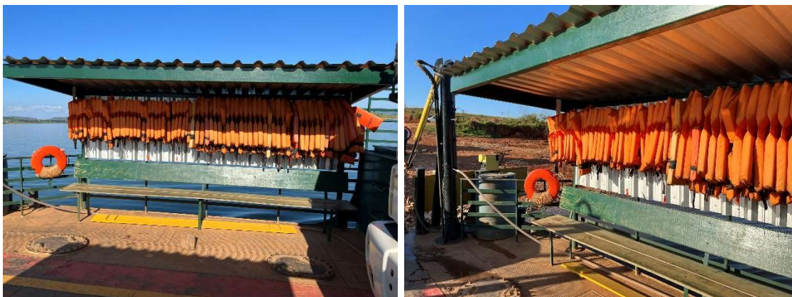
Figura 97 - Porto Araúna - Balsa São Francisco I – Vista Lateral - Equipamentos Salvatagem e Abrigo de Passageiros
