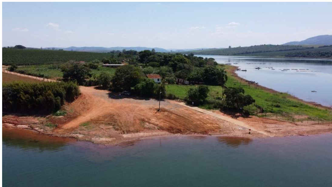
Figura 167 - Porto Itaci – Margem Esquerda
