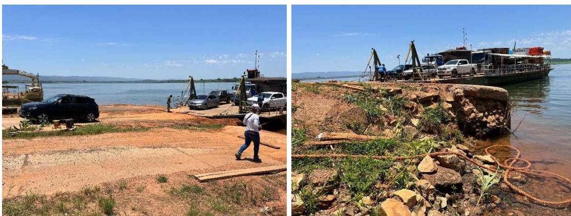
Figura 10 - Porto Delfinópolis - Pátio Terminal - Margem Delfinópolis
