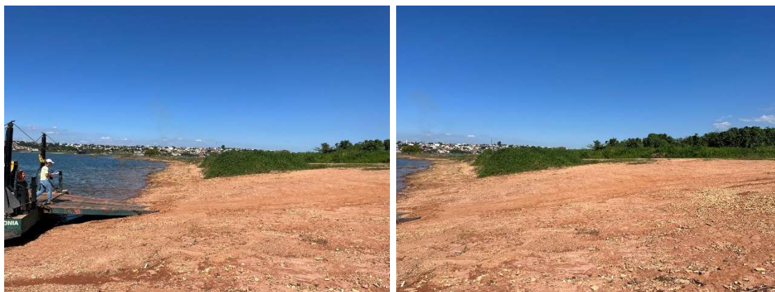
Figura 107 - Porto Barreirinho - Pátio dos Terminais - Margem Esquerda 01
