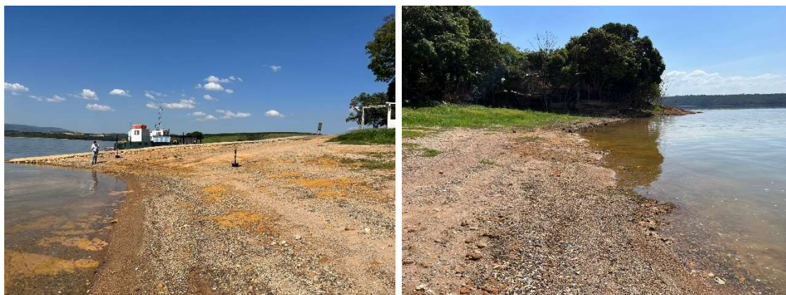
Figura 182 - Área Atual Operacional de Atracação - Margem Direita
