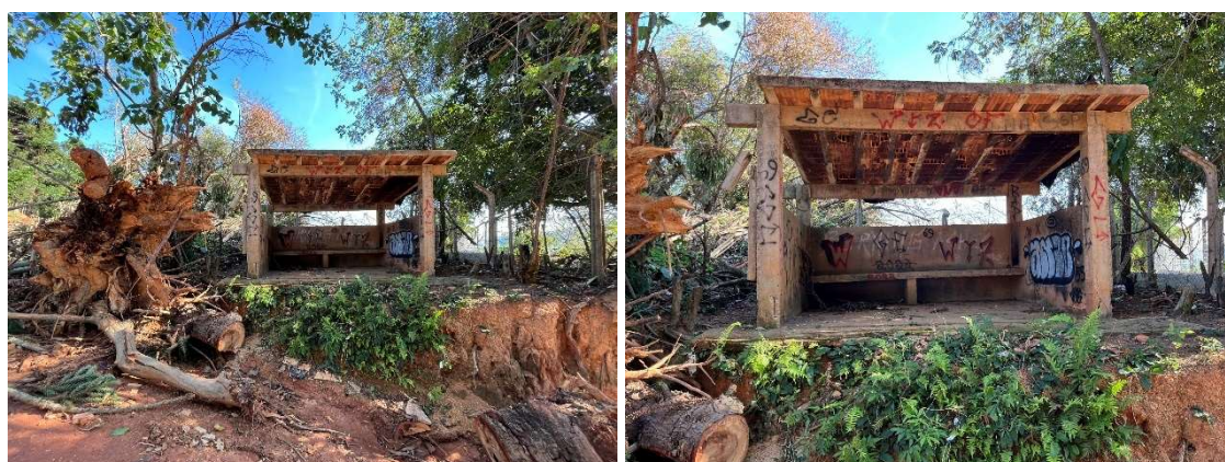
Figura 147 - Porto Itapiché - Pátio do Terminal - Margem Direita – Estrutura de Apoio a População
