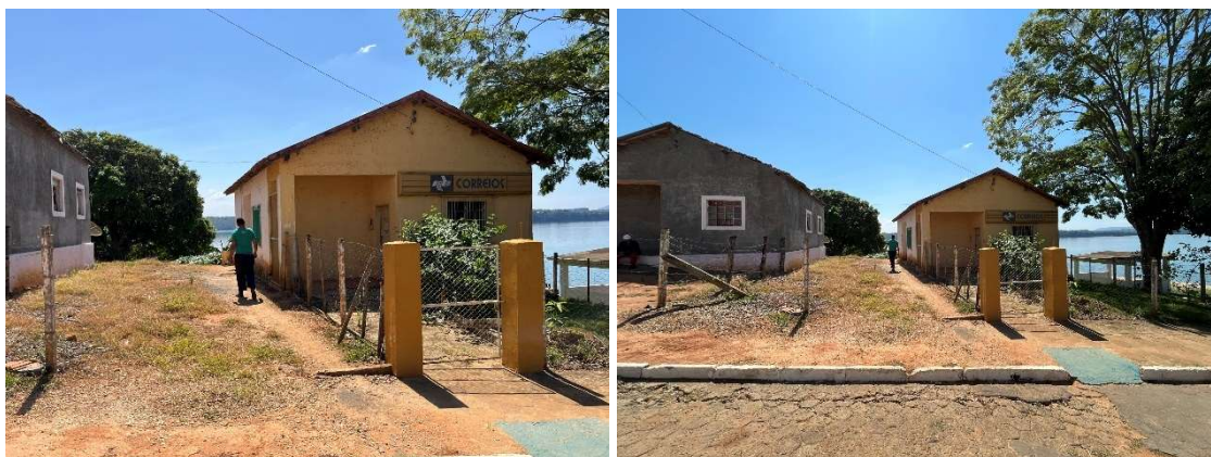
Figura 183 - Porto Itaci - Prédio Apoio - Margem Direita
