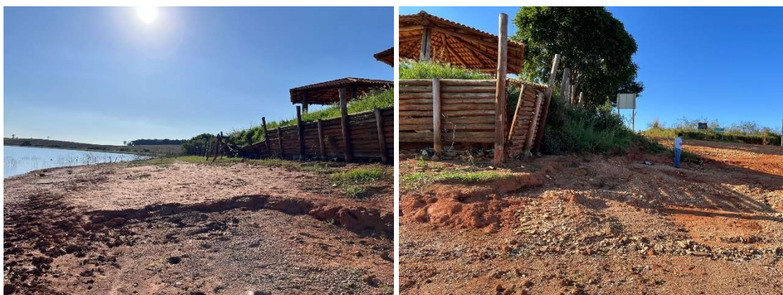
Figura 92 - Porto Araújo - Pátio do Terminal - Margem Direita
