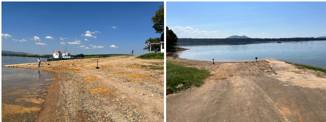
Figura 176 - Porto Itaci - Pátio do Terminal - Margem Direita
