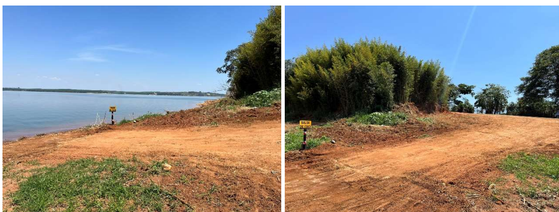
Figura 174 - Porto Itaci - Área Atual Operacional de Atracação - Margem Esquerda
