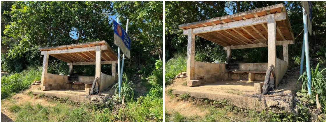
Figura 201 - Porto Águas Verdes – Abrigo para Passageiros - Margem Carmo do Rio Claro
