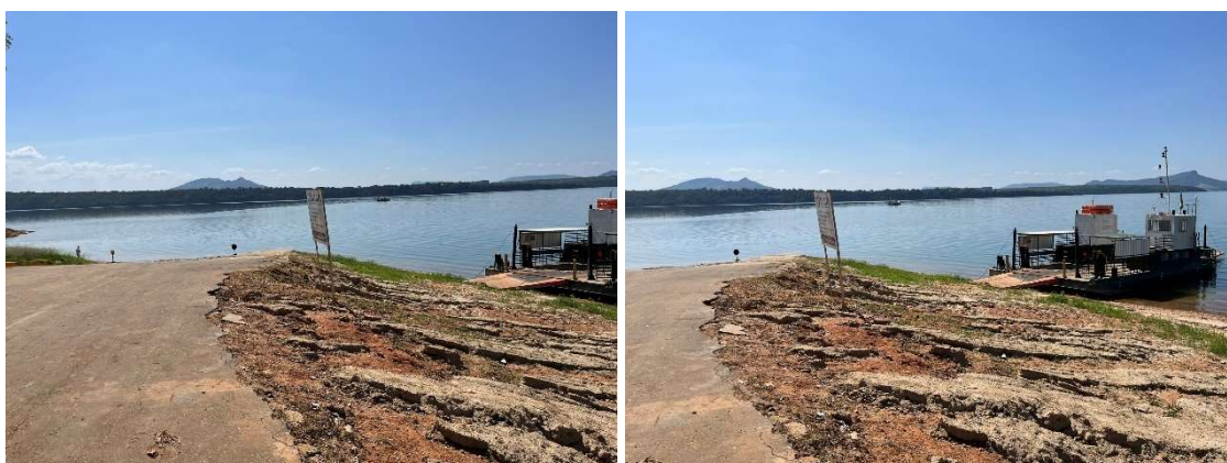
Figura 177 - Porto Itaci - Pátio do Terminal - Margem Direita
