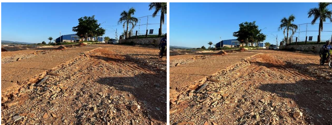
Figura 80 - Porto de Araúna - Pátio do Terminal - Margem Esquerda
