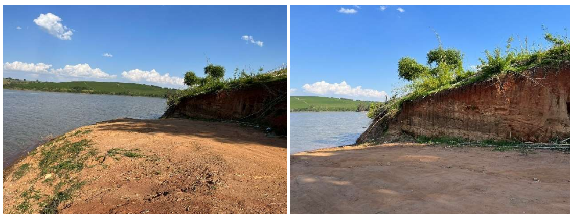
Figura 274 - Porto Pontalete - Pátio Terminal
