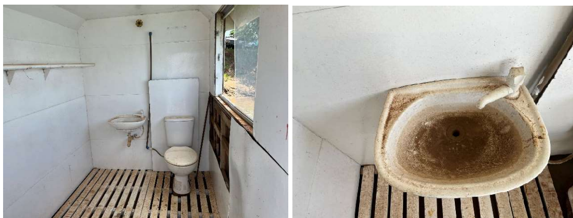
Figura 42 - Balsa Delfinópolis I - Banheiro
