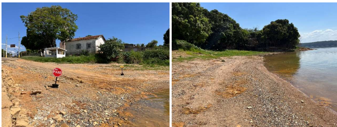
Figura 178 - Porto Itaci - Pátio do Terminal - Margem Direita
