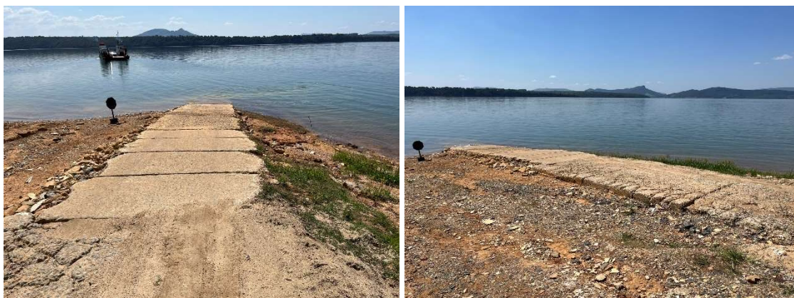
Figura 179 - Porto Itaci - Margem Direita - Atracadouro Existente
