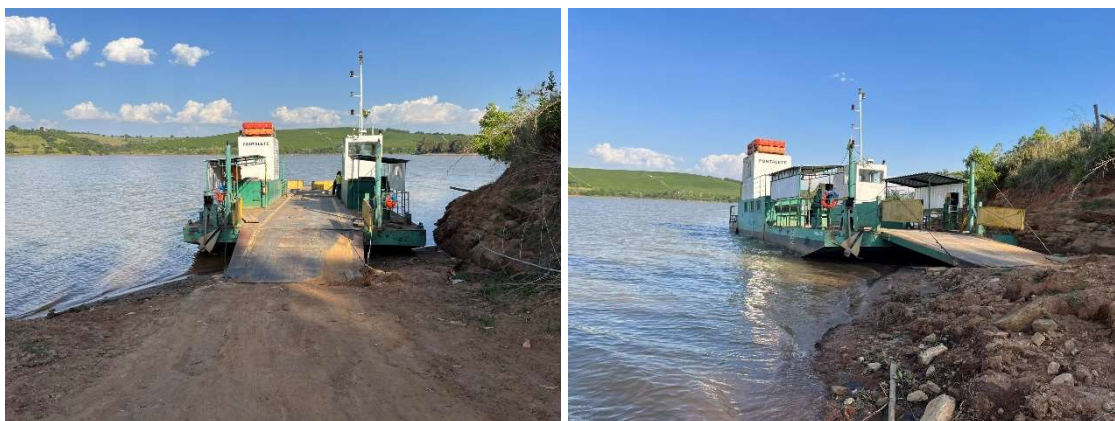
Figura 276 - Porto Pontalete - Área de Atracação - Margem Paraguaçu
