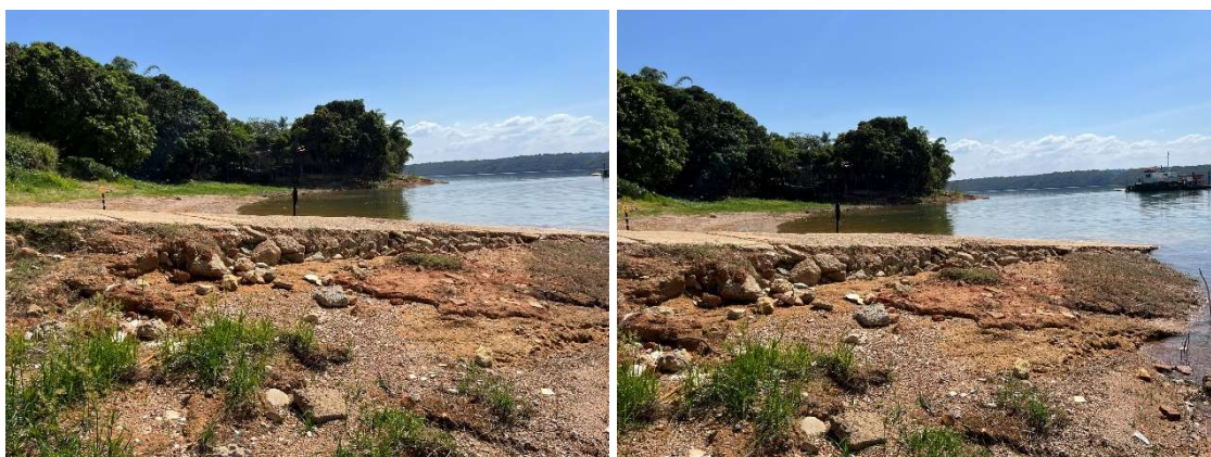
Figura 180 - Porto Itaci - Margem Direita - Atracadouro Existente
