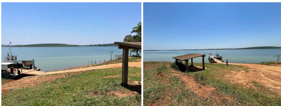
Figura 127 - Porto Fernandes - Pátio Margem Cristais
