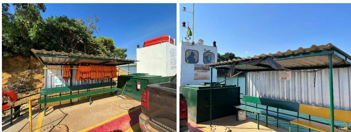
Figura 209 - Porto Águas Verdes - Balsa São Francisco III - Área de Apoio aos Passageiros
