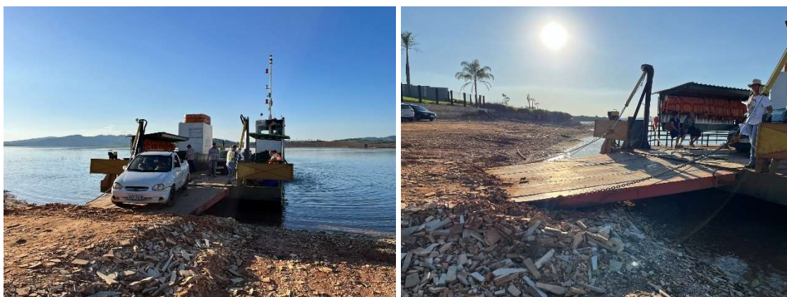
Figura 85 - Porto Araújo –Atracadouro com Elevação de Nível com Aterro - Margem Esquerda
