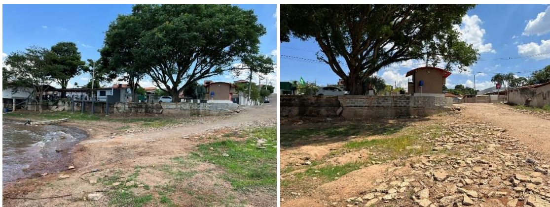
Figura 250 - Porto Fama - Pátio do Terminal - Margem Fama
