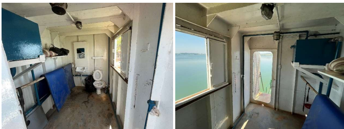
Figura 240 - Porto Harmonia - Balsa Fama - Banheiro
