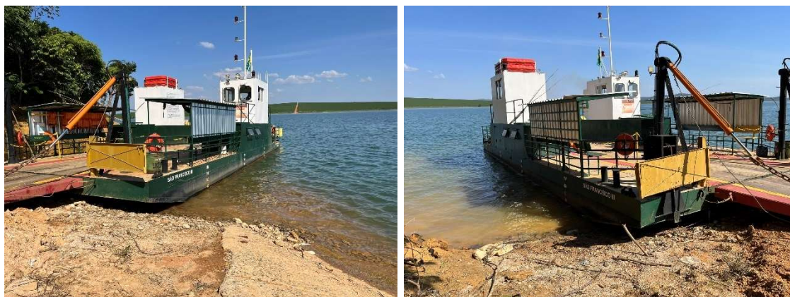
Figura 206 - Porto Águas Verdes - Balsa São Francisco III - Vista Lateral
