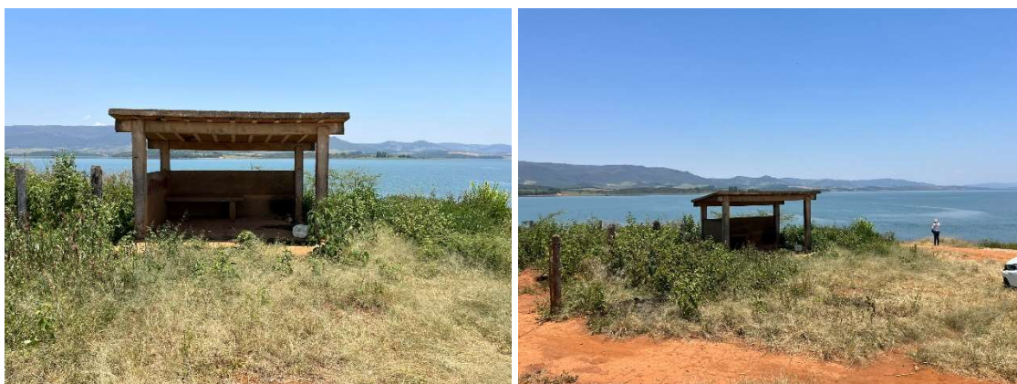
Figura 125 - Porto Fernandes - Pátio Margem Cássia - Estrutura de Apoio a População
