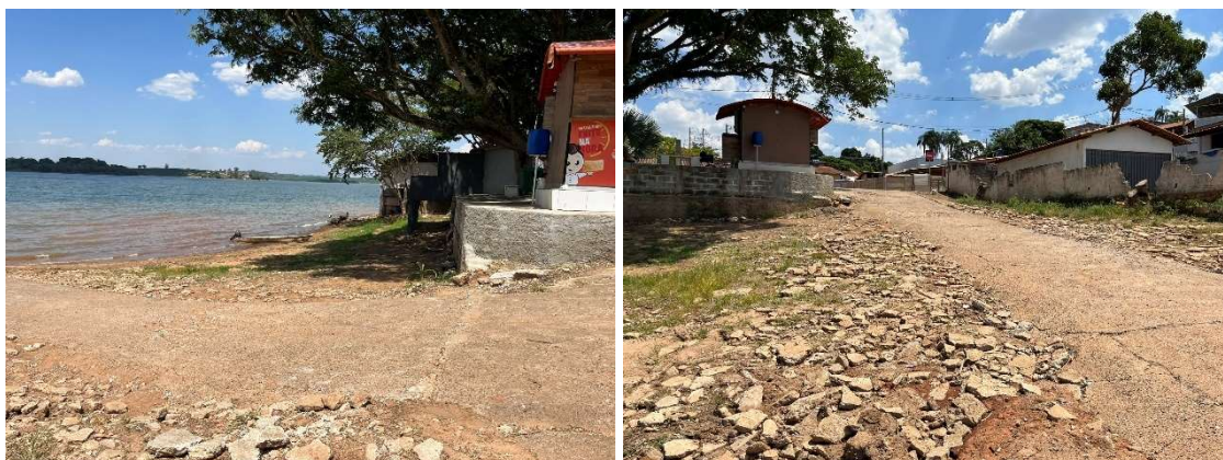
Figura 255 - Porto Fama - Atracadouro Existente - Margem Fama
