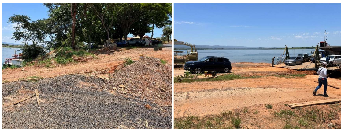
Figura 9 - Porto Delfinópolis - Pátio Terminal - Margem Delfinópolis
