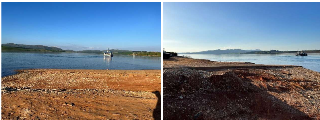
Figura 84 - Porto Araújo - Atracadouro Existente - Margem Esquerda
