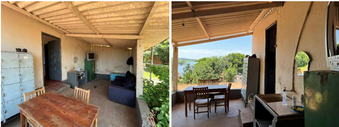
Figura 19 - Porto Delfinópolis - Prédio Administrativo
