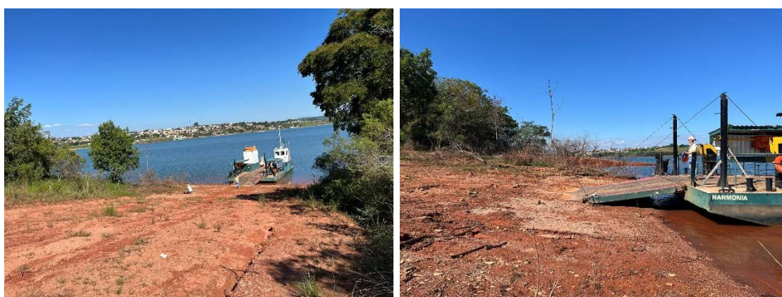
Figura 109 - Porto Barreirinho - Pátio dos Terminais - Margem Esquerda 02
