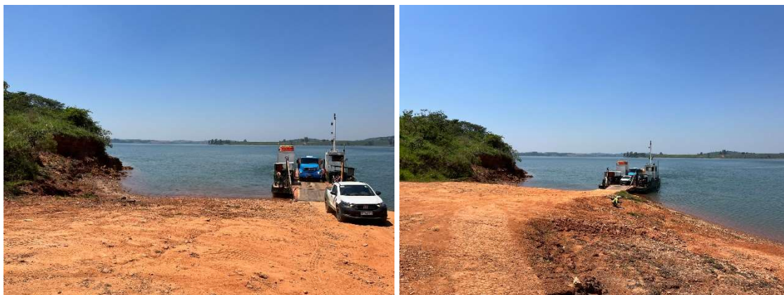
Figura 224 - Porto Harmonia - Pátio dos Terminais - Margem Centro
