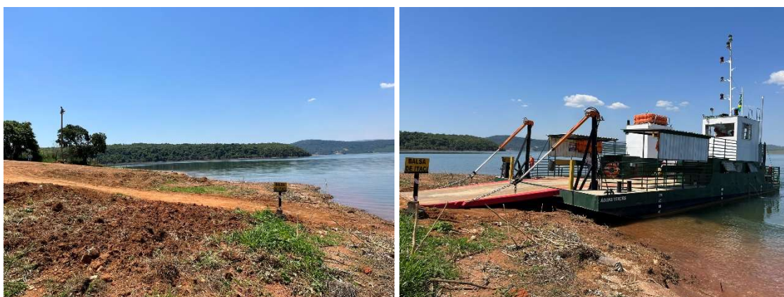
Figura 175 - Porto Itaci - Área Atual Operacional de Atracação - Margem Esquerda
