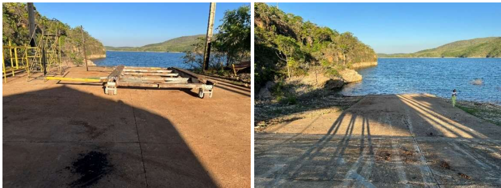
Figura 5 – Estaleiro FURNAS – Rampa de Atracação
