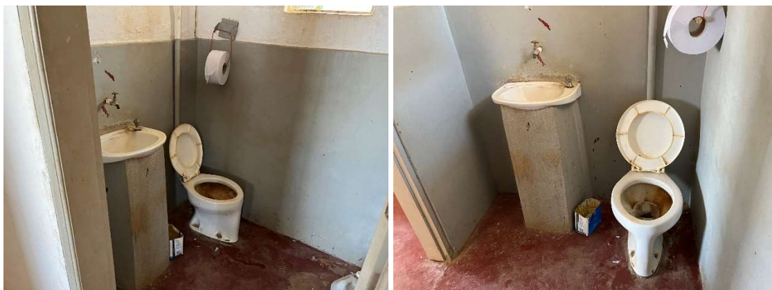
Figura 187 - Porto Itaci - Prédio Apoio - Banheiro - Margem Direita
