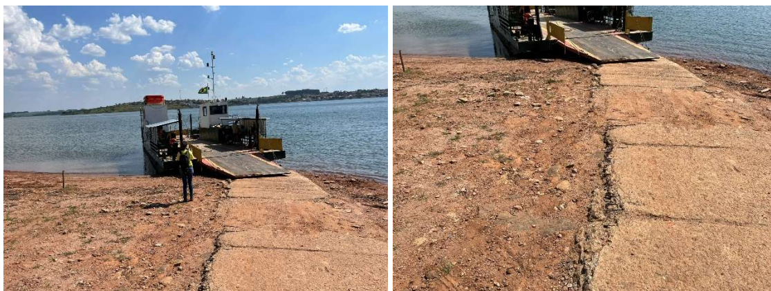
Figura 252 - Porto Fama - Atracadouro Existente - Margem Campos Gerais
