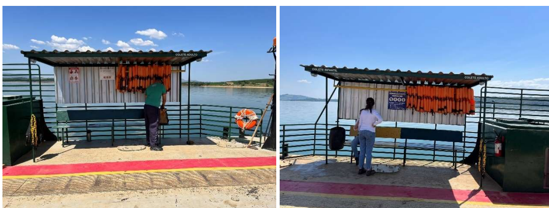
Figura 192 - Porto Itaci - Balsa Águas Verdes – Área de Apoio a População
