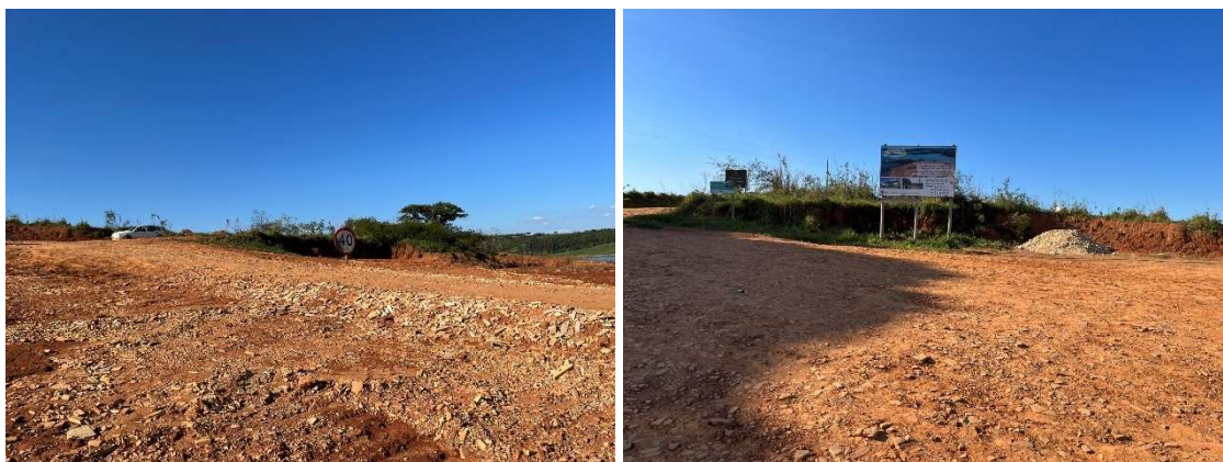
Figura 89 - Porto Araújo - Pátio do Terminal - Margem Direita
