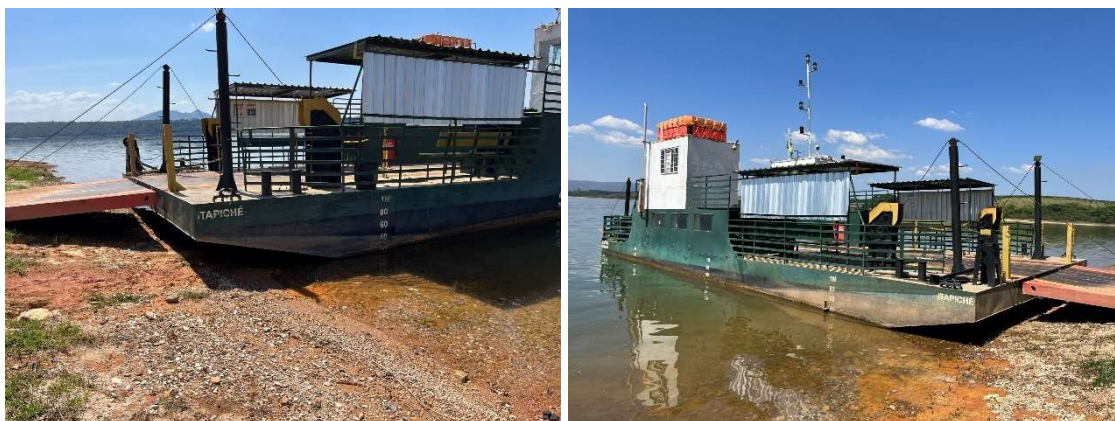
Figura 154 - Balsa Itapiché - Vista Lateral
