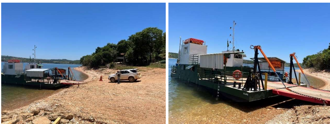
Figura 66 - Porto Pontal/Penas - Atracação - Margem Guapé
