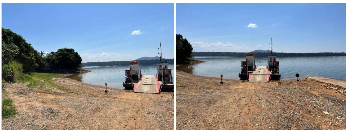
Figura 181 - Área Atual Operacional de Atracação - Margem Direita
