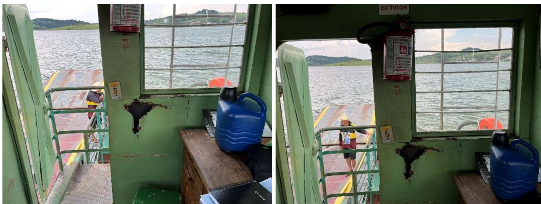
Figura 299 - Porto Mendes - Balsa Saliba - Cabine de Operação
