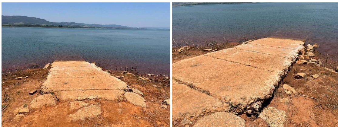
Figura 130 - Porto Fernandes - Atracadouro Margem Guapé
