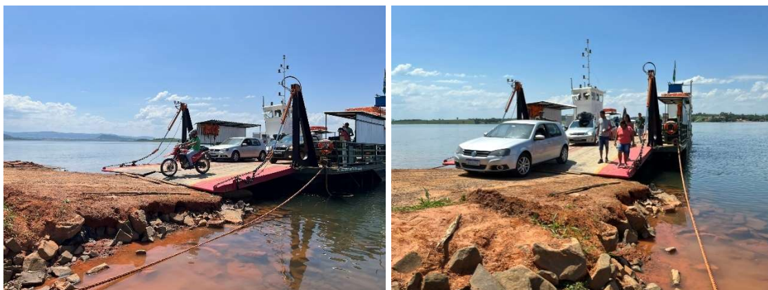
Figura 25 - - Porto Delfinópolis - Atracadouro Operacional 02 - Margem Cássia
