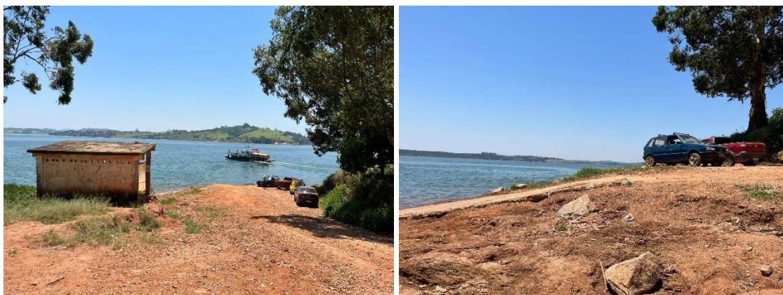
Figura 232 - Porto Harmonia - Pátio do Terminal - Margem Esquerda
