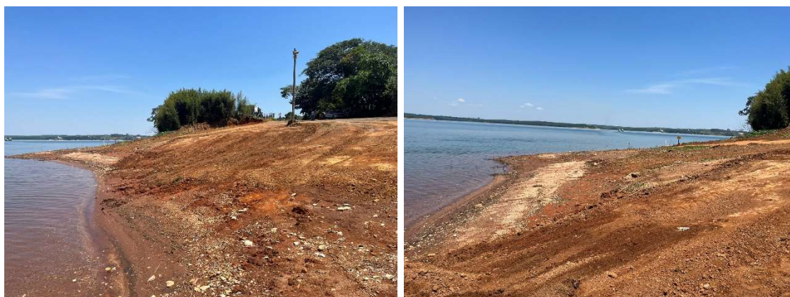
Figura 170 - Porto Itaci - Pátio do Terminal - Margem Esquerda
