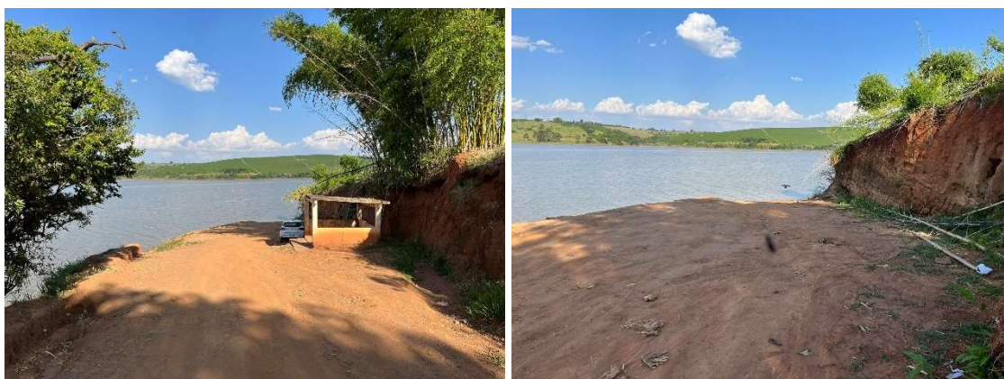
Figura 273 - Porto Pontalete - Pátio Terminal
