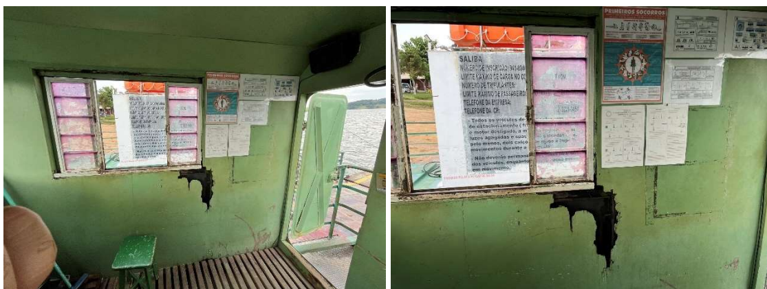
Figura 300 - Porto Mendes - Balsa Saliba - Cabine de Operação
