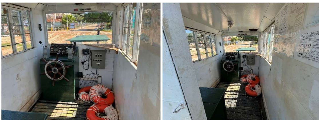
Figura 157 - Balsa Itapiché - Vista Casa do Operador
