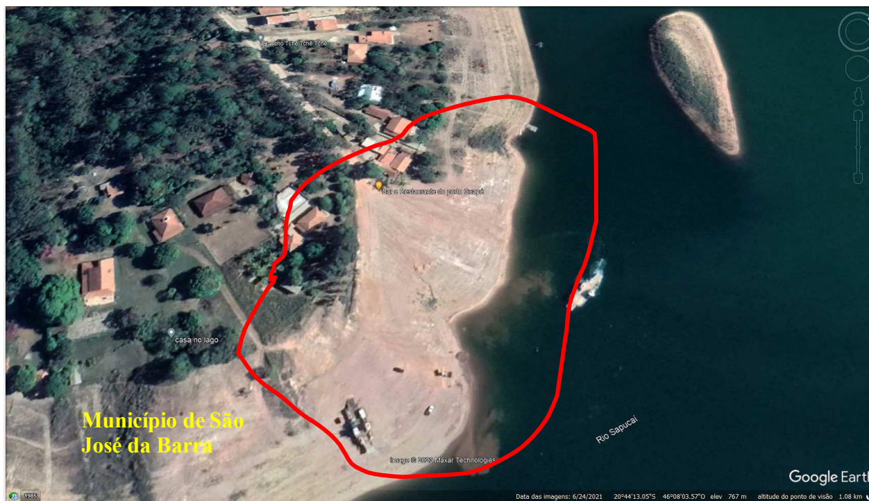
3.2-3 – UHE Furnas – Porto Pontal/Penas – Detalhe do atracadouro
