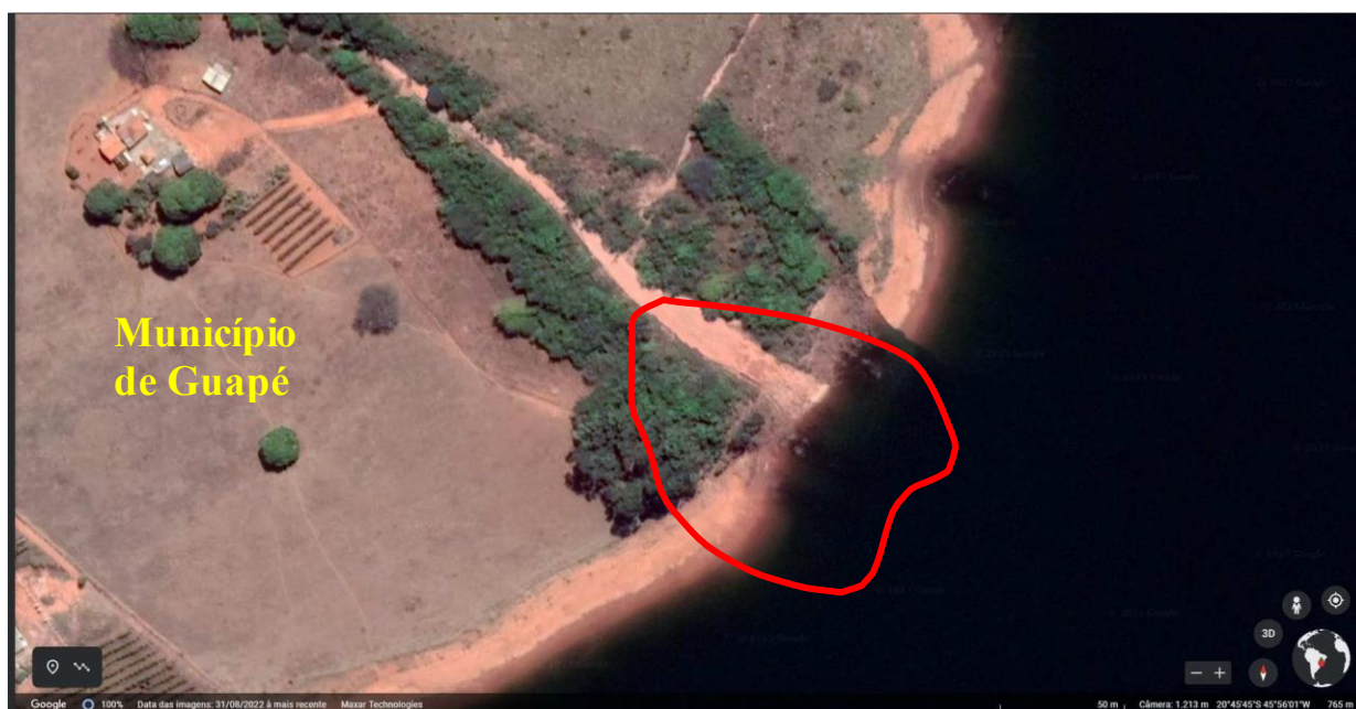
3.4-4 – UHE Furnas – Porto Barreirinho – Detalhe do atracadouro
