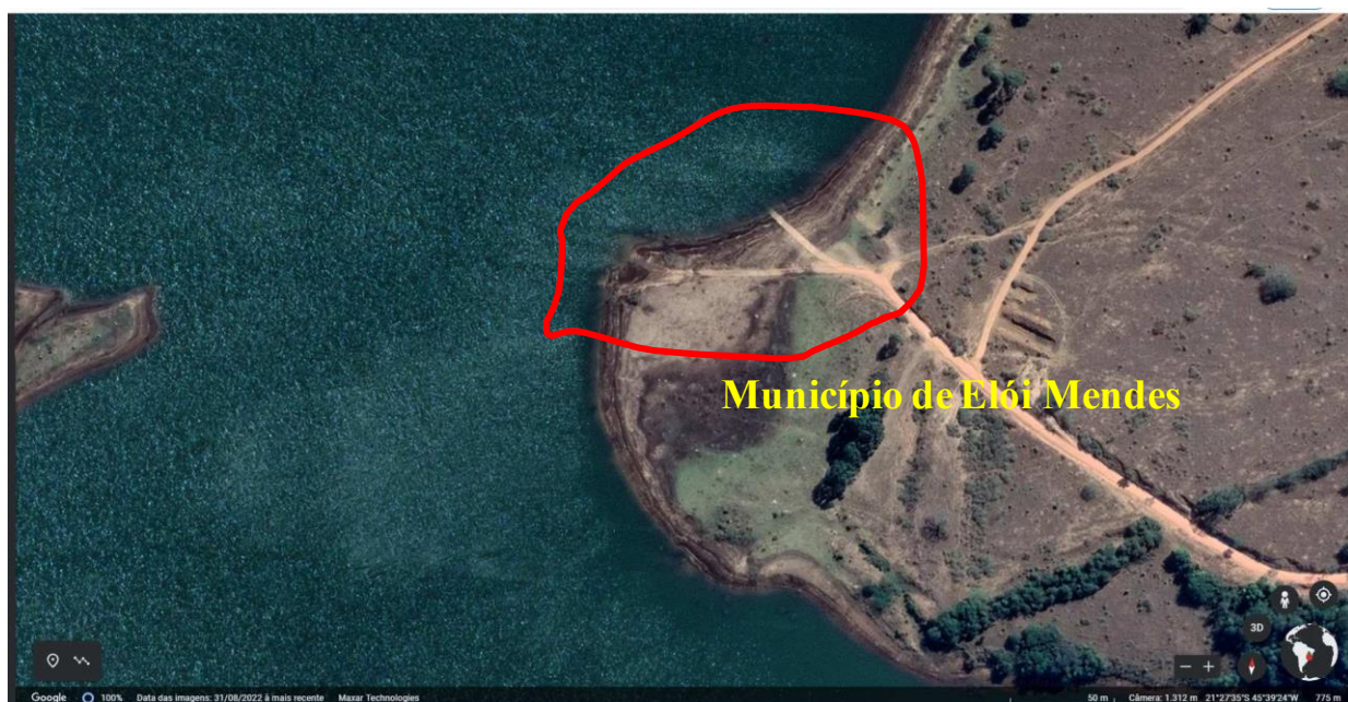
3.11-4 – UHE Furnas – Porto Pontaleta – Detalhe do atracadouro
