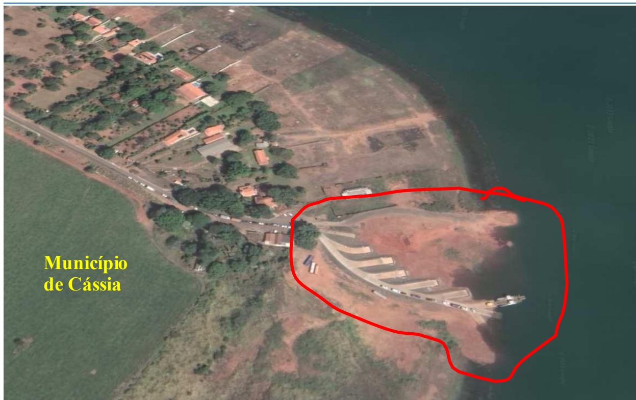
3.1-3 – UHE Mascarenhas de Moares – Porto Delfinópolis - Detalhe do Atracadouro em Concreto
