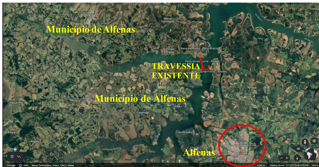
3.9-1 – UHE Furnas – Porto Harmonia - Vista de situação
