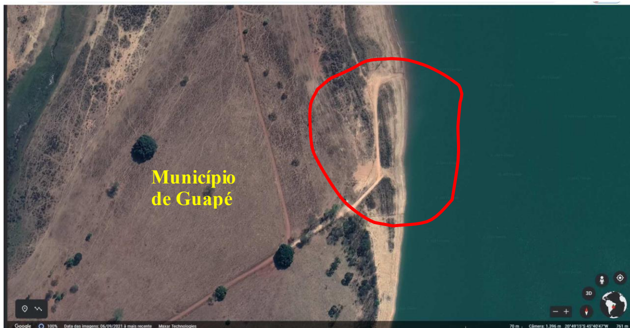
3.5-4 – UHE Furnas – Porto Fernandes – Detalhe do atracadouro
