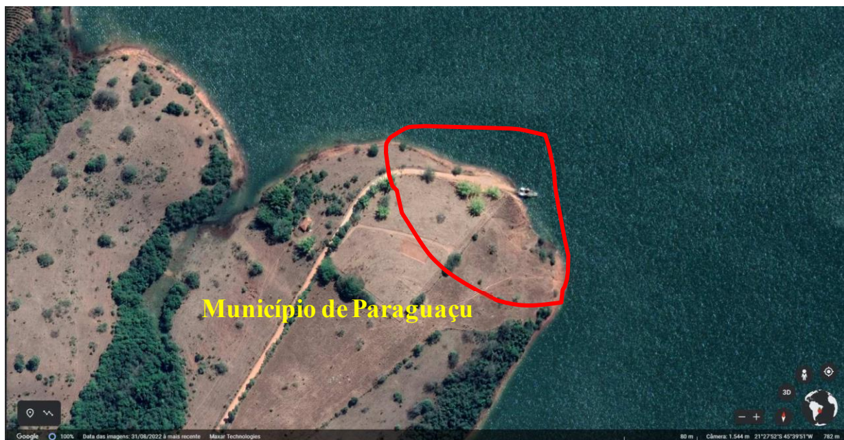
3.11-3 – UHE Furnas – Porto Pontaleta – Detalhe do atracadouro
