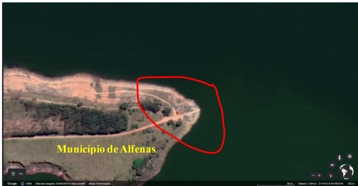
3.9-4 – UHE Furnas – Porto Harmonia – Detalhe do atracadouro
