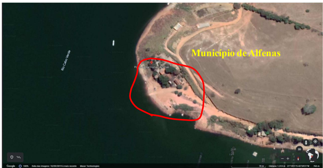
3.9-5 – UHE Furnas – Porto Harmonia – Detalhe do atracadouro
