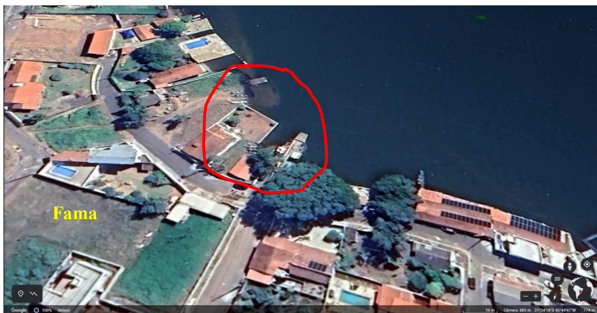
3.10-4 – UHE Furnas – Porto Fama – Detalhe do atracadouro
