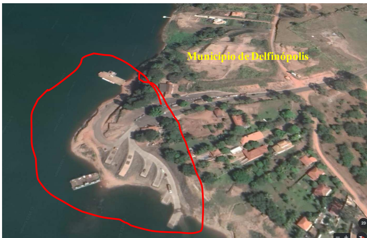
3.1-4 – UHE Mascarenhas de Moares – Porto Delfinópolis - Detalhe do Atracadouro em Concreto
