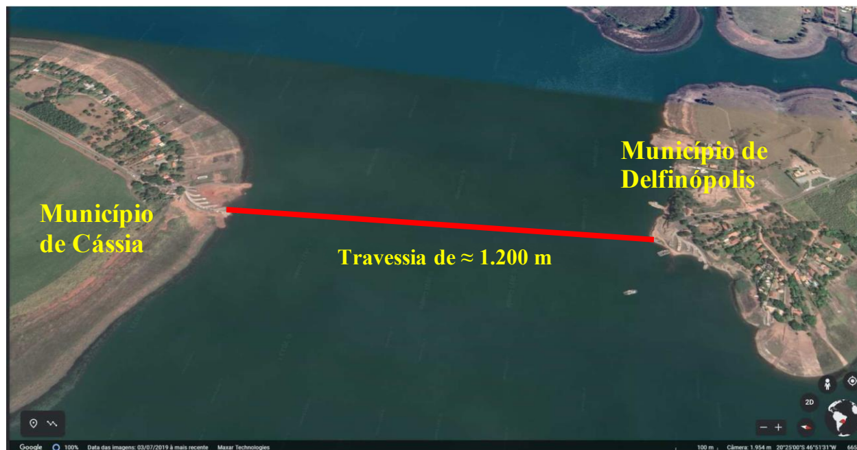
3.1-2 – UHE Mascarenhas de Moraes – Porto Delfinópolis – Vista da Travessia existente
