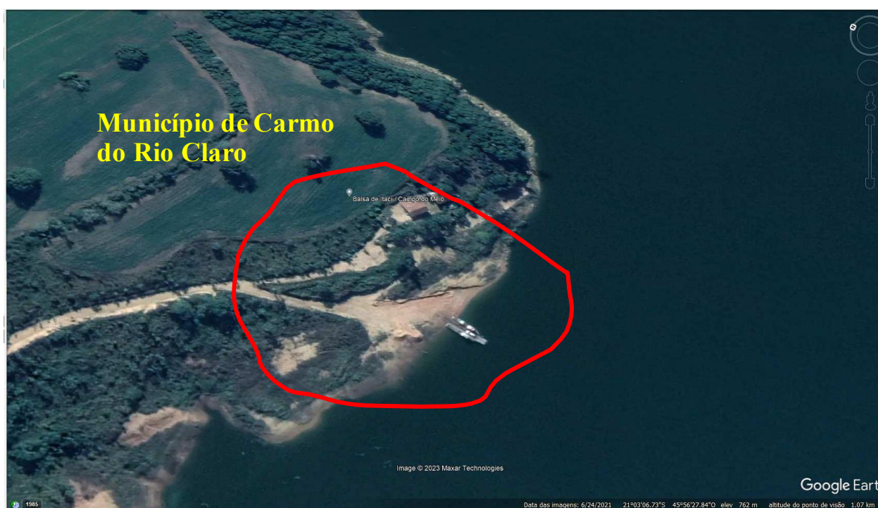
3.8-3 – UHE Furnas – Porto Águas Verdes – Detalhe do atracadouro
