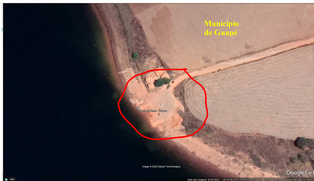
3.3-4 – UHE Furnas – Porto Araúna – Detalhe do atracadouro
